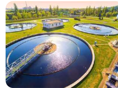
Tratamiento de agua
